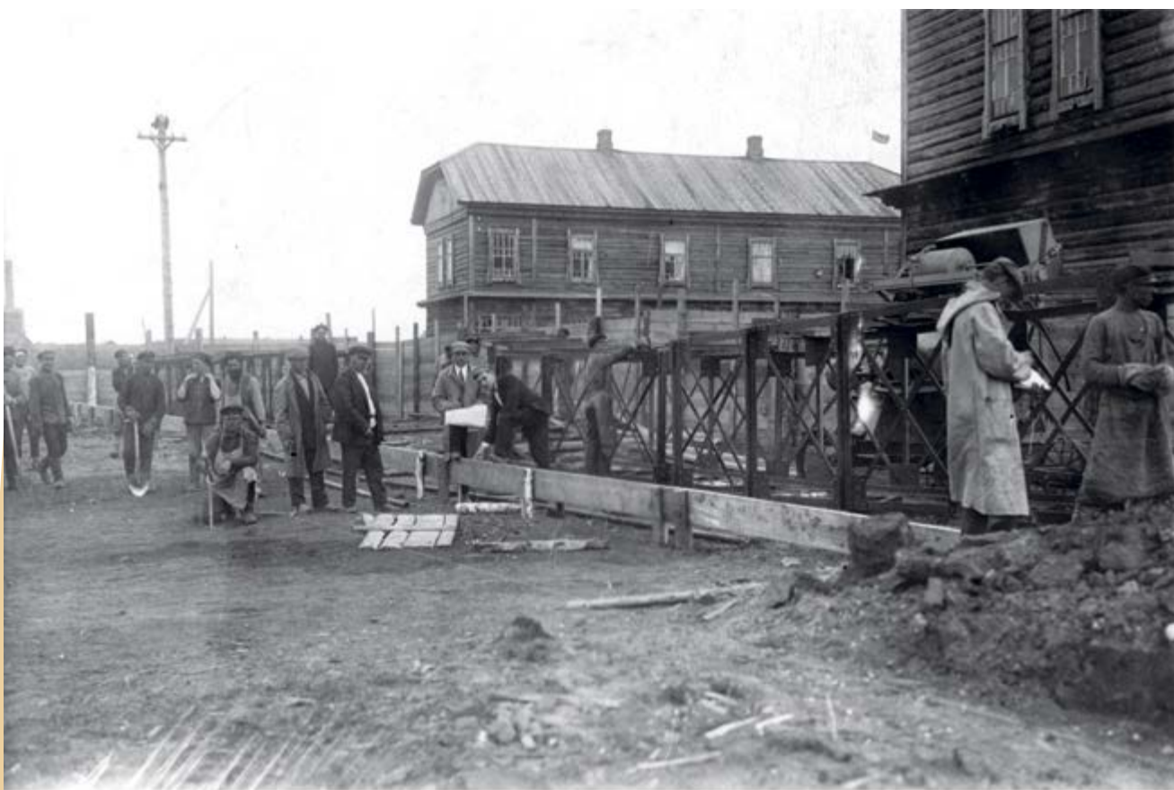
ГКУ КО ГАКО. Фотофонд. Оп.8д. Д.616. Л.1. Строительство жилых домов на Нижней Колонии. Консолимазавод г.Щегловск, 1924 г.
