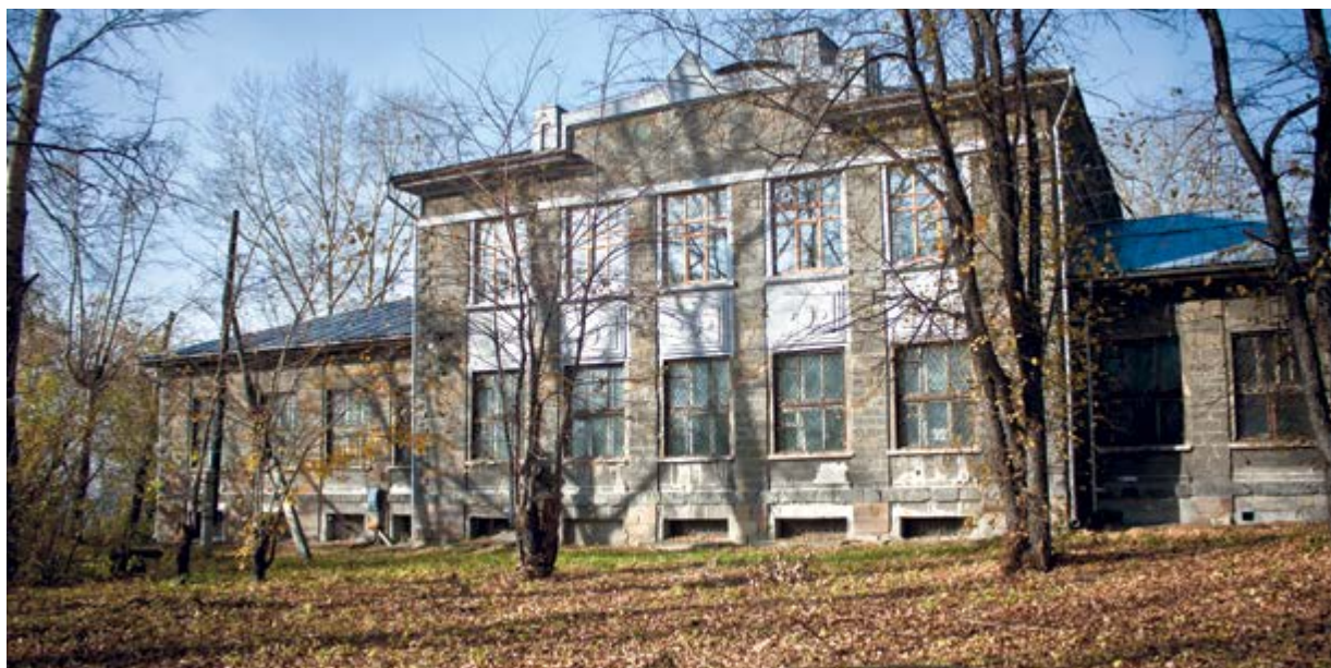
Главная контора Кемеровского рудника, современное состояние
