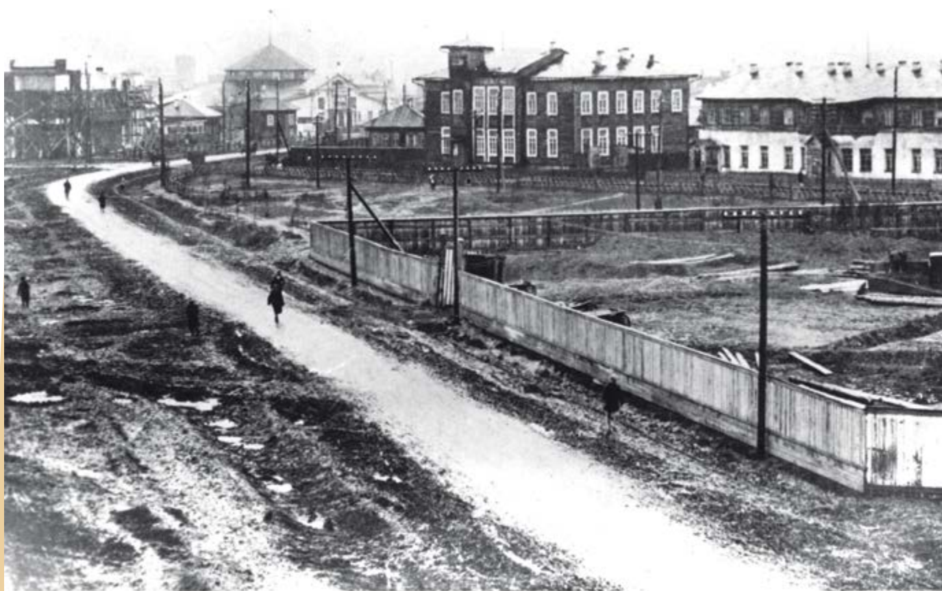
ГКУ КО ГАКО. Фотофонд. Оп.10. Д.198. Л.1. Площадка для строительства кинотеатра Москва г.Кемерово, 1935 г.
