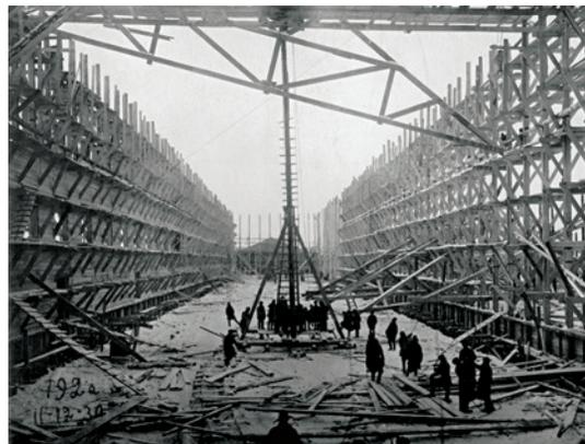
Установка стропильных ферм на строительстве тепляков коксовых печей. 1930.
